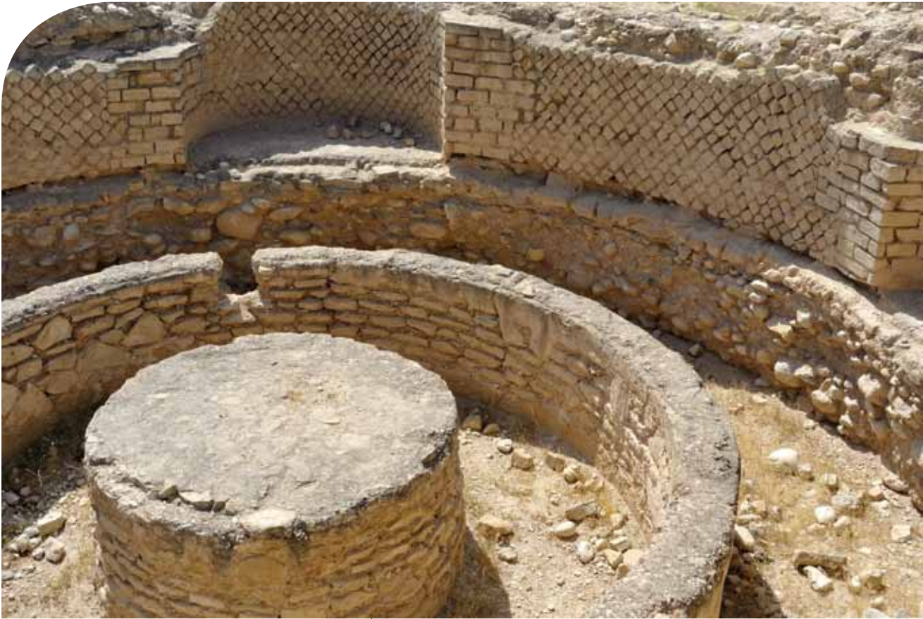
ארמונות החשמונאים ביריחו כללי בנייה בטכניקה מיוחדת המכונה אופוס רטיקולטוס שבה הונחו הלבנים באלכסון. ניתן להבחין בבנייה הייחודית גם כיום, למרות הפגיעה הקשה בחבנים כתוצאה מההנהגה רבת שנים. שרידים באזור הארמונות כיום צילום: shutterstock
